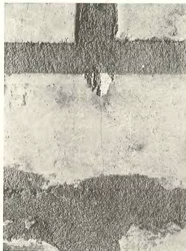
Fig. 27. Sten i CmM-Pille, afskallet og revnet som Følge af Stødfugens koncentrerede Tryk 1) .
